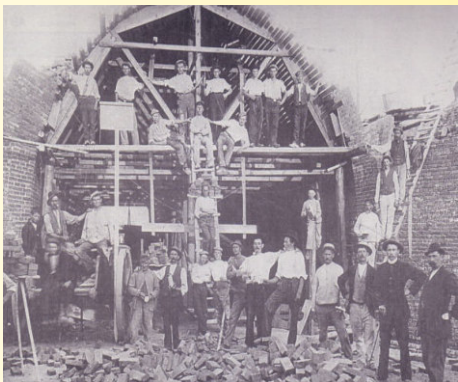
Tunnelbau Reststrauch um 1902
